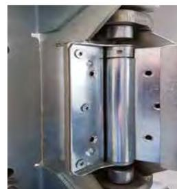
Paumelle à ressort assurant fermeture et verrouillage automatiques
