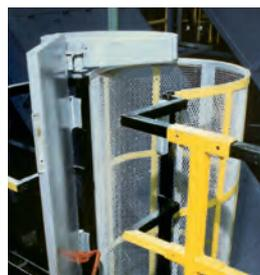
Lors de rotation du panneau, l'opercule supérieur pivote latéralement pour dégager la crinoline
